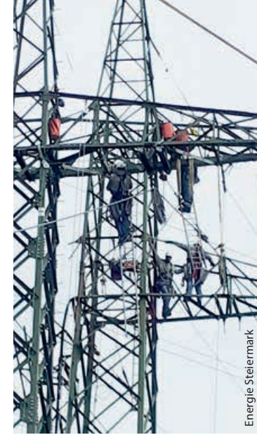
Monteure auf einer 110-kV-Leitung, das Netz ist gesamt 33.300 km lang.
