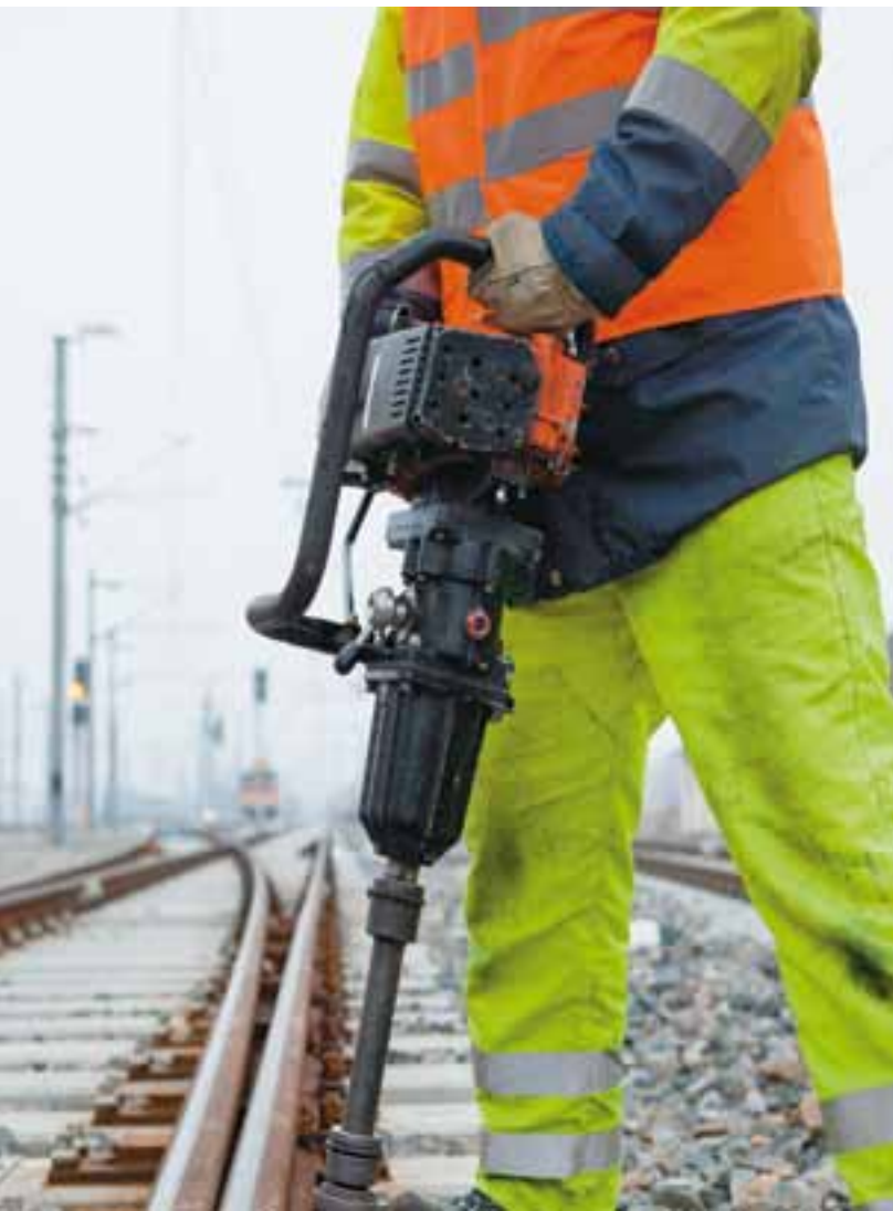
Für Arbeiten im Freien gibt es keine Temperaturuntergrenze. (Fotolia)
